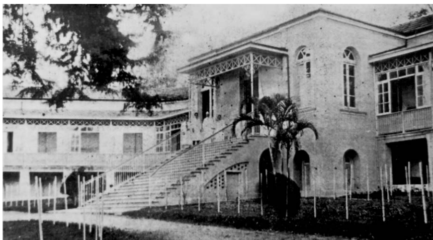
Hospital de isolamento Cícero Ferreira, construído em 1910: primeiro estabelecimento para o tratamento de doenças transmissíveis. Belo Horizonte, MG.
